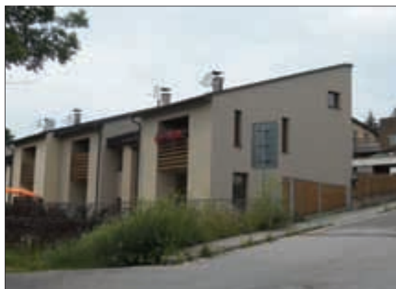
Místo bývalého lágru, dnes vilová čtvrť Sluneční vrch u autobusového nádraží
