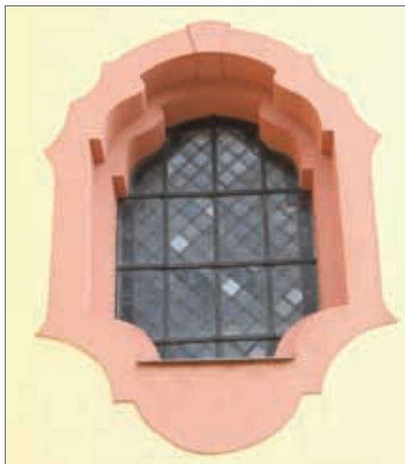
Barokní okno zdobené, kostel sv. Vavřince, Jilemnice
