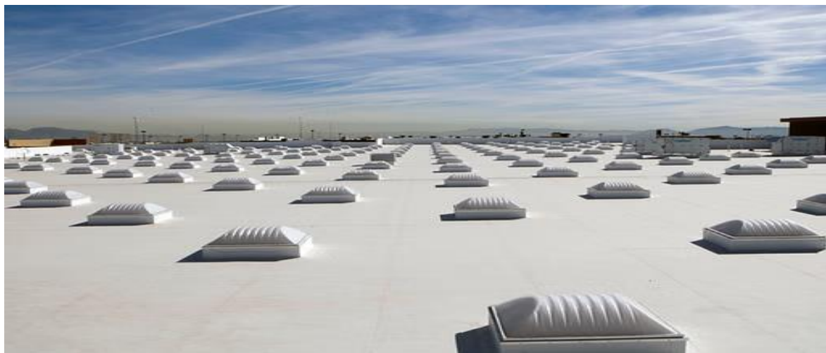
Foto 16 – Chladná střecha s odrazivou fólií, zdroj: Archinect News
