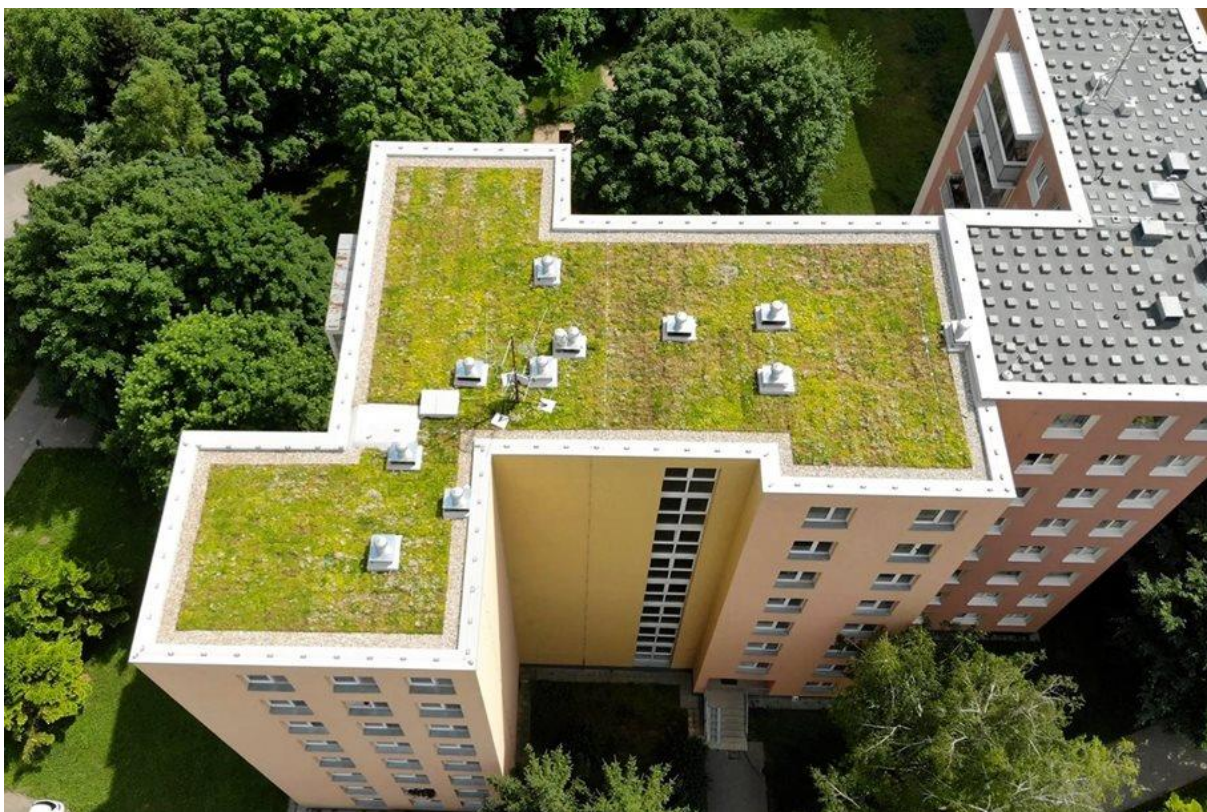
Foto 13 – Zelená střecha na panelovém domě, ilustrační foto, zdroj Adaptera 2021
