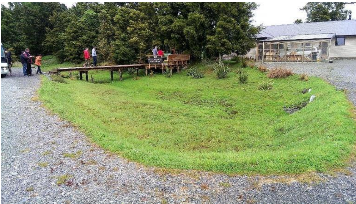
Foto 12 – Zavodňovací příkop (prohlubeň) pro zachyt dešťové vody ze silnice, ilustrační foto, zdroj ASIO
